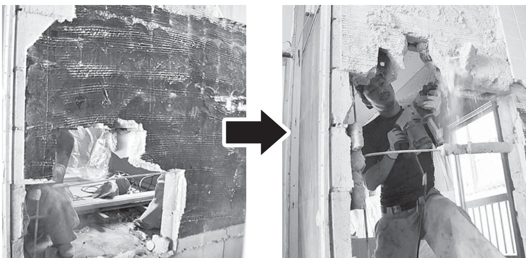
▲壁とタイルを剥がすなど、一つひとつの作業に技術と経験がいる
