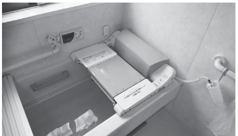
▲入浴を補助する昇降機。手すりには事故防止のチャイムを設置している(岡本さん提供写真)
