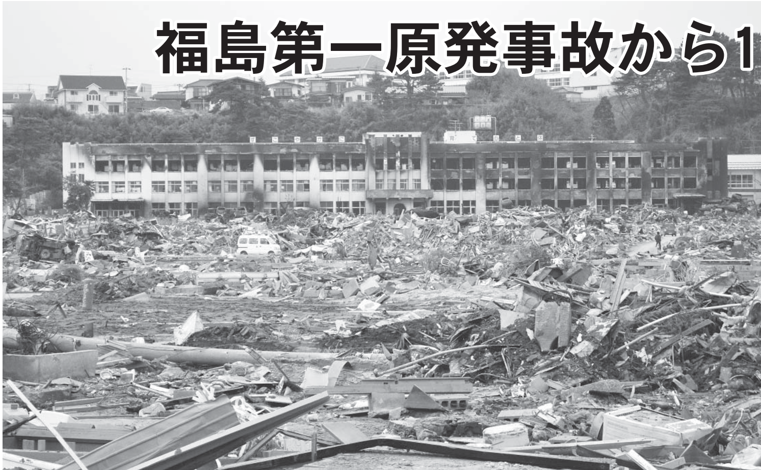
津波の被害を受けた石巻市の小学校(2011年3月30日、宮城)
