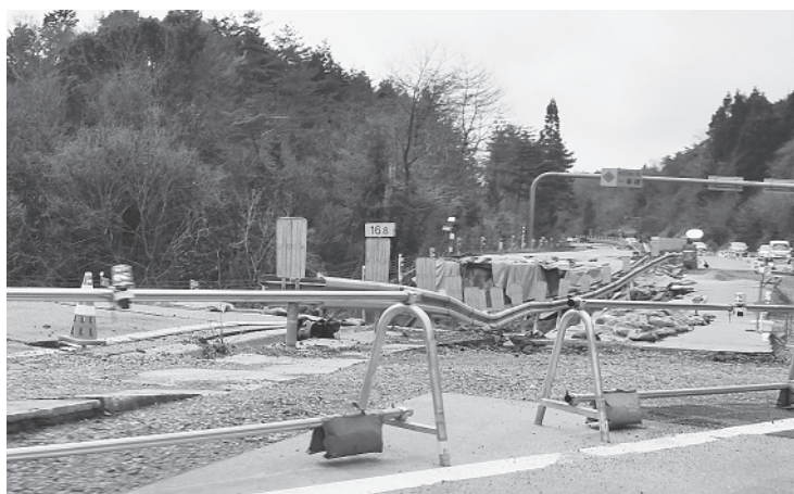
▲羽咋市から輪島市に向かう道路にできた大きな陥没。道路のそこかしこが陥没しており、そこを避けるように道が曲がりくねっているため移動に時間がかかる(4月17日)
